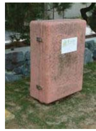
〈32〉消火ホース格納箱
