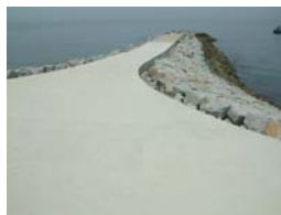
〈1〉養浜突堤2(第2突堤)
