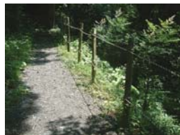
〈14〉転落防止柵 3 (トヨタ®)
