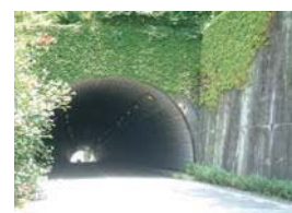
〈33〉新二見トンネル
