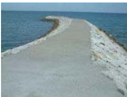
〈1〉養浜突堤1(第1突堤)
